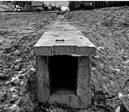
270 метров, - рассказал прораб. - Так как сток проходит по покатуму рельефу, глубина траншеи под ливневые лотки в разных точках неодинаковая. Самое глубокое место находится в начале канала - 3 метра 20 сантиметров. Оно же для нас было самым трудным, потому что стенки траншеи то и дело осыпались, а сама она наполнялась водой. Но сейчас водосток не кажется таким глубоким, потому что часть пространства заполнено подстилающим слоем из щебня и 70 сантиметров «съели» сами лотки.
